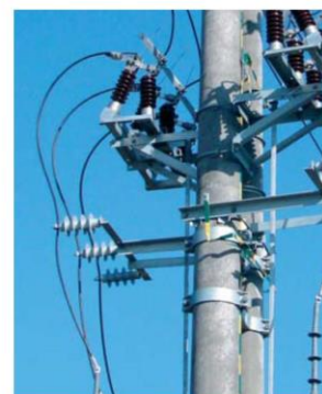
zabezpieczenie kabla SN – zejście z linii napowietrznej
