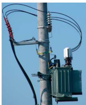
zabezpieczenie uproszczonej stacji transformatorowej 15/0,4 kV
