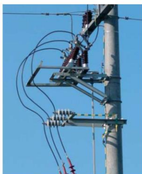
zabezpieczenie kabla SN – zejście z linii napowietrznej
